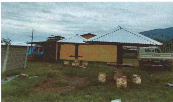
FOTO 17: SUSTITUCION DE LAMINAS, POR LAMINAS ALUZIN CALIBRE 26
