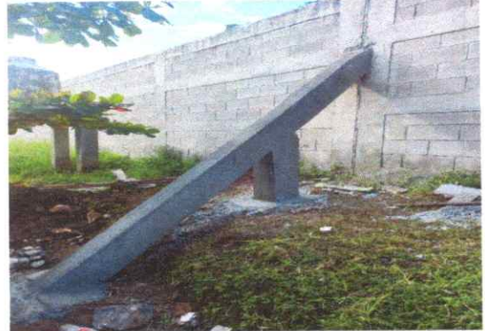
FOTO 8. REPARACION DE UNA COLUMNA DE MURO PERIMETRAL.
