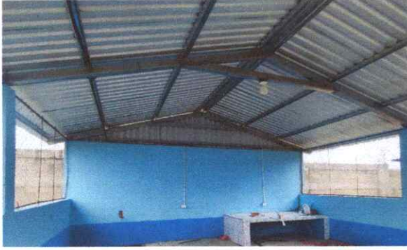
FOTO 13. SUSTITUCION DE ESTRUCTURA PORTANTE DE METAL
