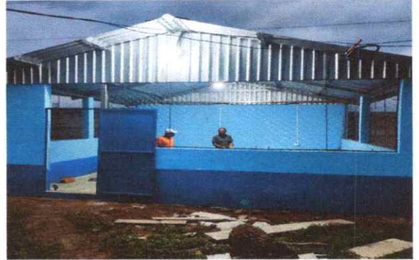
FOTO 14. INSTALACION DE LAMINAS TROQUELADA ALUZINC CALIBRE 26
