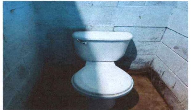
FOTO 18: SUSTITUCION DE ACCESORIOS INODORO
