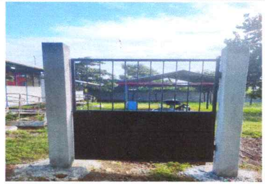
FOTO 4. SUSTITUCION DE PORTON 2, POR PORTON DE METAL.
