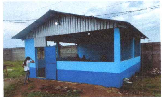
FOTO 12: SUSTITUCION DE MALLA DE COCINA RURAL
