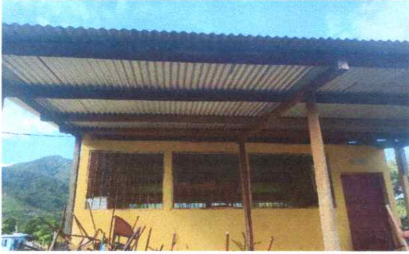
FOTO 1. SUSTITUCION DE LAMINAS POR LAMINA TROQUELADA CALIBRE 26.
