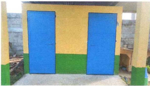
FOTO 5. SUSTITUCION DE PUERTA DE MADERA POR METAL.
