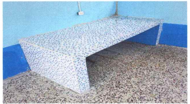
FOTO 16. REPARACION DE MESA DE CONCRETO
