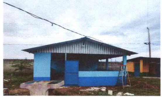
FOTO 2. SUSTITUCION DE ESTRUCTURA DE SOPORTE DE MADERA POR METAL.
