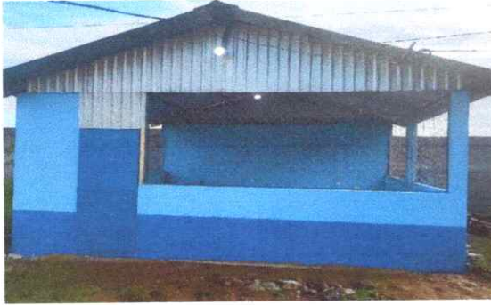
FOTO 7. PINTURA EN MUROS EXTERIORES E INTERIORES.
