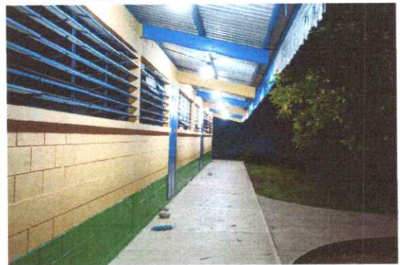
FOTO 10. SUSTITUCION DE FOCOS AHORADORAS
