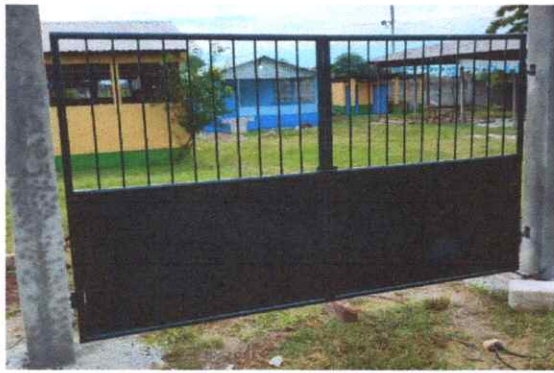
FOTO 3. SUSTITUCION DE PORTON 1, POR PORTON DE METAL.
