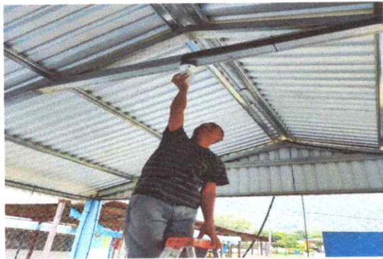
FOTO 9. SUSTITUCION DE PLAFOMERAS
