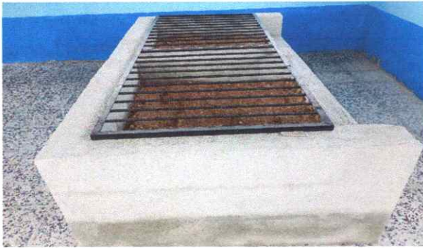
FOTO 15. MANTENIMIENTO DE ESTUFA RURAL
