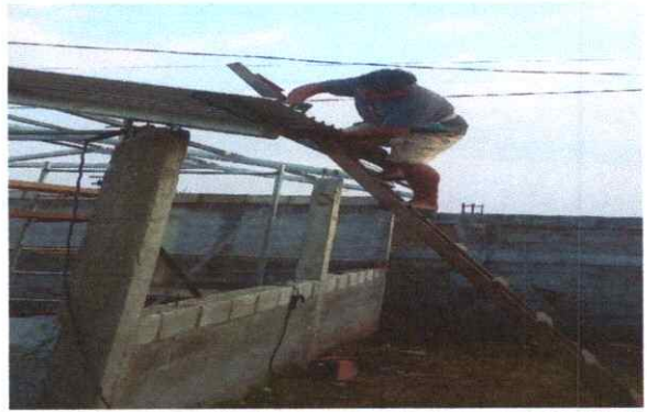
FOTO 14. INSTALACION DE LAMINAS TROQUELADA ALUZINC CALIBRE 26
