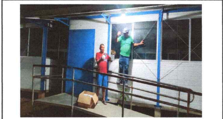
FOTO 10: SUSTITUCION DE FOCOS AHORRADORES
