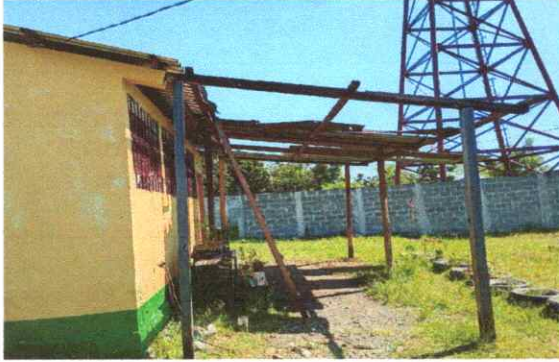
FOTO 1. SUSTITUCION DE LAMINAS POR LAMINA TROQUELADA CALIBRE 26.
