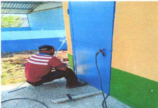
FOTO 5. SUSTITUCION DE PUERTA DE MADERA POR METAL.
