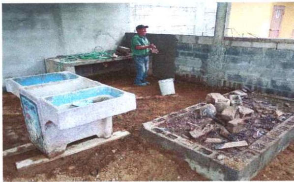
FOTO 15. MANTENIMIENTO DE ESTUFA RURAL
