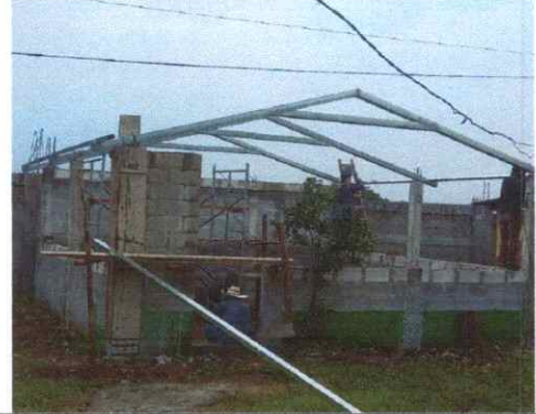
FOTO 2. SUSTITUCION DE ESTRUCTURA DE SOPORTE DE MADERA POR METAL.
