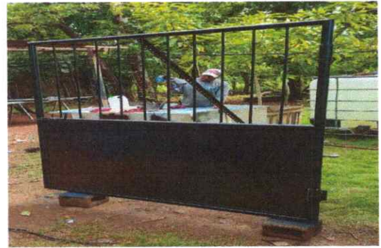
FOTO 4. SUSTITUCION DE PORTON 2, POR PORTON DE METAL.
