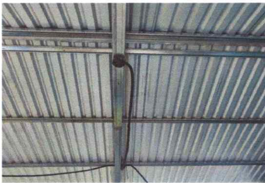
FOTO 9. SUSTITUCION DE PLAFOMERAS
