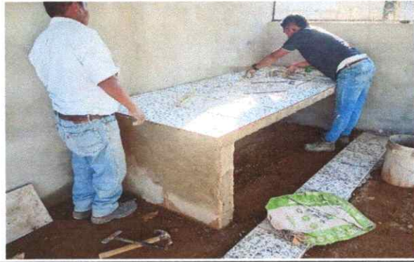
FOTO 16. REPARACION DE MESA DE CONCRETO
