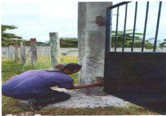
FOTO 3. SUSTITUCION DE PORTON 1, POR PORTON DE METAL.
