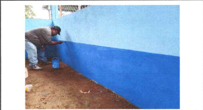
FOTO 7. PINTURA EN MUROS EXTERIORES E INTERIORES.
