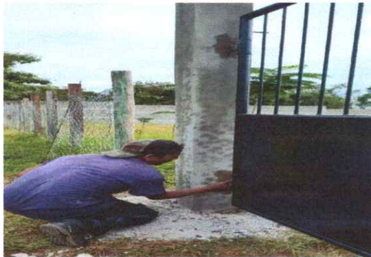
FOTO 3. SUSTITUCION DE PORTON 1, POR PORTON DE METAL.
