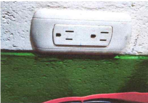
FOTO 11. SUSTITUCION DE TOMACORRIENTES DOBLES
