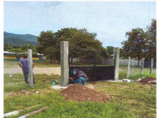
FOTO 4. SUSTITUCION DE PORTON 2, POR PORTON DE METAL.
