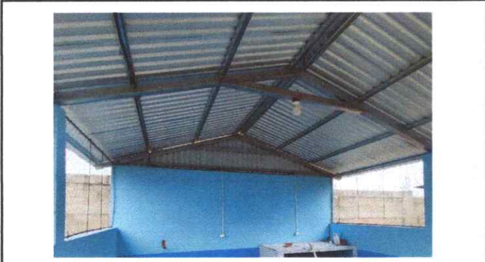
FOTO 9. SUSTITUCION DE PLAFOMERAS
