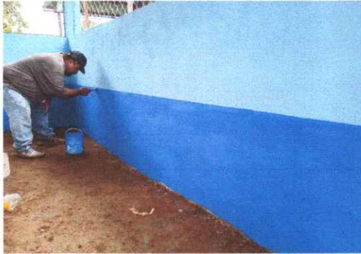
FOTO 7. PINTURA EN MUROS EXTERIORES E INTERIORES.
