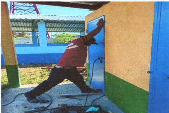
FOTO 5. SUSTITUCION DE PUERTA DE MADERA POR METAL.
