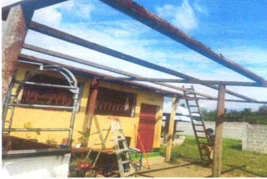
FOTO 1. SUSTITUCION DE LAMINAS POR LAMINA TROQUELADA CALIBRE 26.
