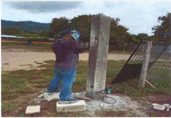
FOTO 3. SUSTITUCION DE PORTON 1, POR PORTON DE METAL.
