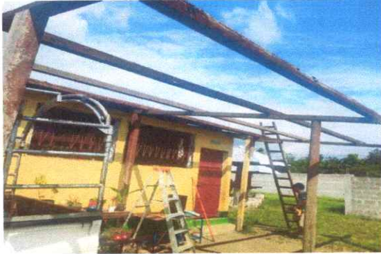
FOTO 1. SUSTITUCION DE LAMINAS POR LAMINA TROQUELADA CALIBRE 26.
