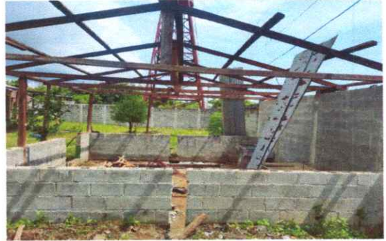
FOTO 2. SUSTITUCION DE ESTRUCTURA DE SOPORTE DE MADERA POR METAL.
