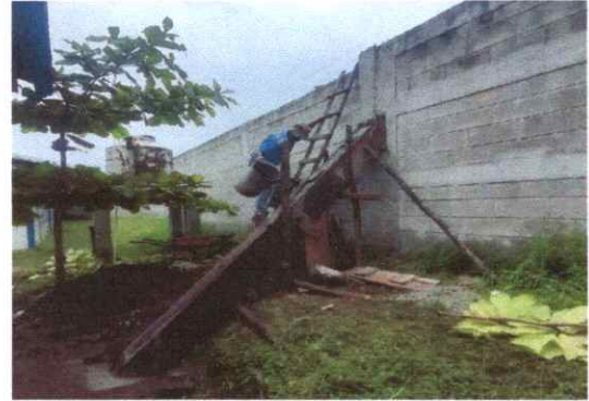
FOTO 8. REPARACION DE UNA COLUMNA DE MURO PERIMETRAL.
