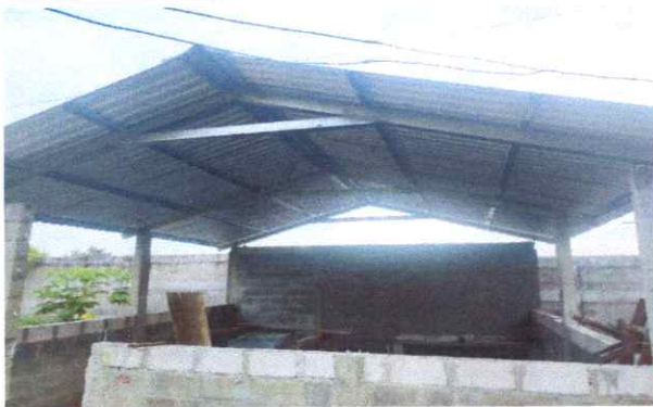
FOTO 13. SUSTITUCION DE ESTRUCTURA PORTANTE DE METAL
