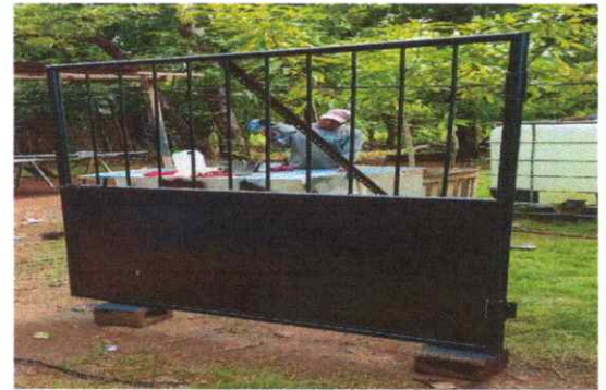
FOTO 4. SUSTITUCION DE PORTON 2, POR PORTON DE METAL.
