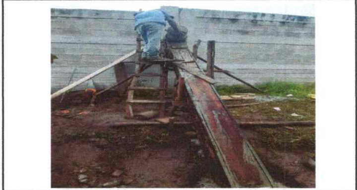
FOTO 8. REPARACION DE UNA COLUMNA DE MURO PERIMETRAL.
