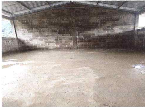
FOTO 3: PISO DE TORTA DE CONCRETO EN AULA ADJUNTA A EORM CON LAS MEDIDAS DE 64 M2
