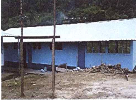
FOTO 1: CONSTRUCCION DE AULA ADJUNTA A EORM CON LAS MEDIDAS DE 64 M2
