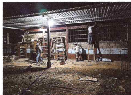
Foto 6: COLOCACION DE BALCANES EN AULA DE COPB ANEXO A EORM
