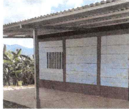
FOTO 2: Sustitución de ventana de madera por metal.
