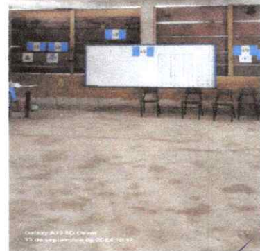
FOTO 4: Sustitución de piso de torta de concreto
