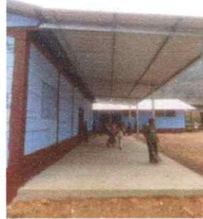
**FOTO 2:** Se observa corredor del modulo 2 con piso y con techo de lámina troqueladas
