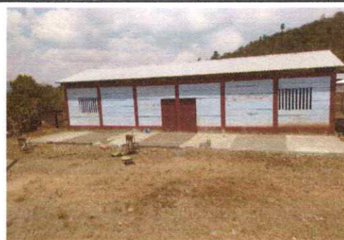
FOTO 6: Fundición de piso de torta de cemento en el corredor de la escuela
