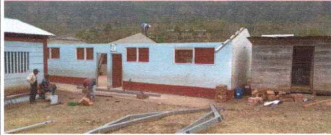
FOTO 2: Inicio de fabricación de estructuras de soporte de metal
