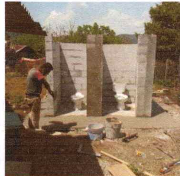
FOTO 4: Construcción de 2 sanitarios lavables
