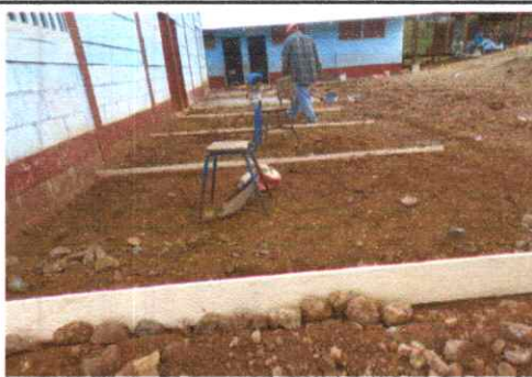
FOTO 5: Inicio de fundición de piso de torta de cemento en el corredor de la escuela
