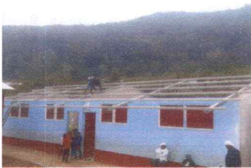
FOTO 3: Instalación de estructuras de soporte de techo de metal
