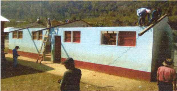
FOTO 1: Desmontaje de techo y estructura de techo existente
