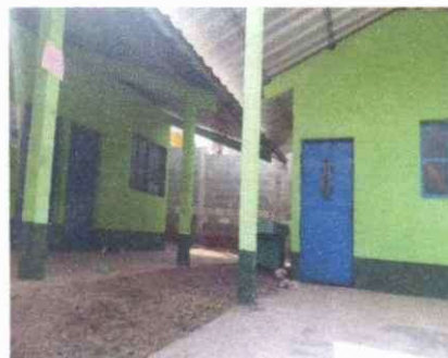
FOTO 4: PINTURA EN MUROS INTERIOR Y EXTERIOR
