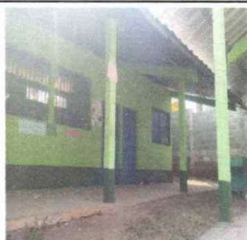
FOTO 5: PINTURA EN MUROS INTERIOR Y EXTERIOR
