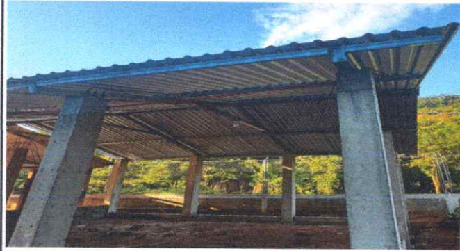
Foto 1, CUBIERTA DE LAMINA.
