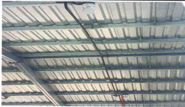
Foto 3: REPARACIÓN DE SISTEMA ELECTRICO.
