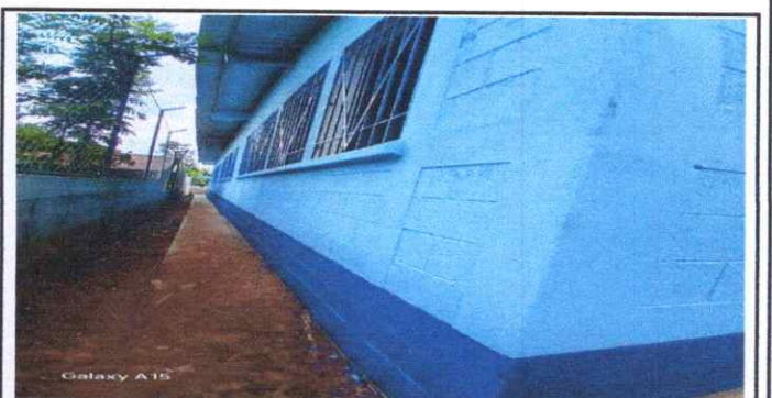
Foto 6: PINTURA EN MUROS EXTERIORES E INFERIORES.
