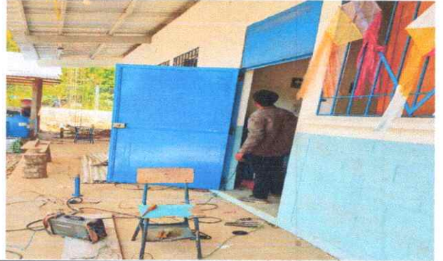
Foto 2: Puertas de Metal.
