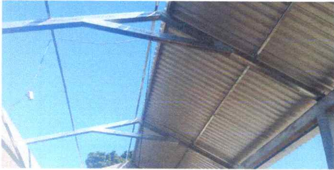
Foto 1, CUBIERTA DE LAMINA.
