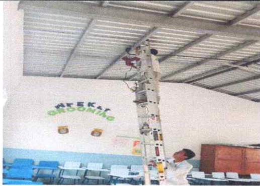
Foto 3: REPARACIÓN DE SISTEMA ELECTRICO.
