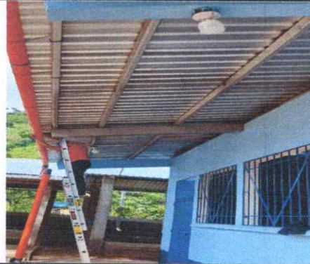
Foto 4: CANALES Y BAJADAS DE AGUA FLUVIAL.
