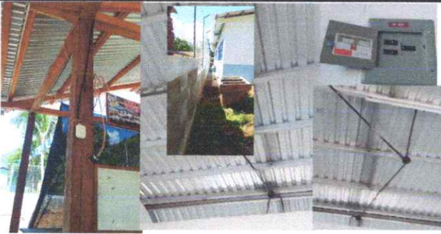
Foto 3: REPARACIÓN DE SISTEMA ELECTRICO
