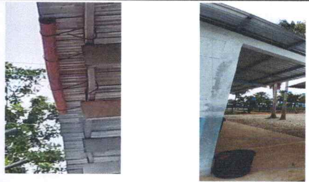
Foto 4: CANALES Y BAJADAS DE AGUA FLUVIAL
