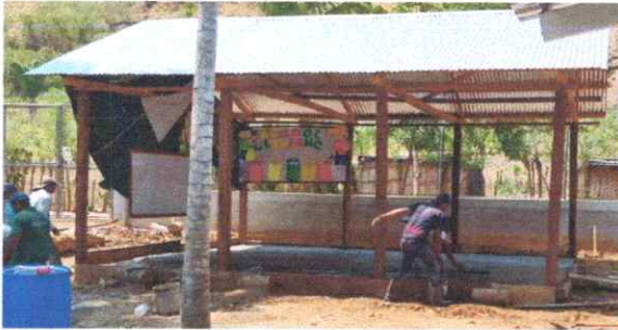
Foto 1, CUBIERTA DE LAMINA
