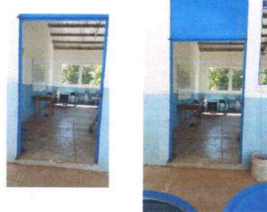
Foto 2: Puertas de Metal
