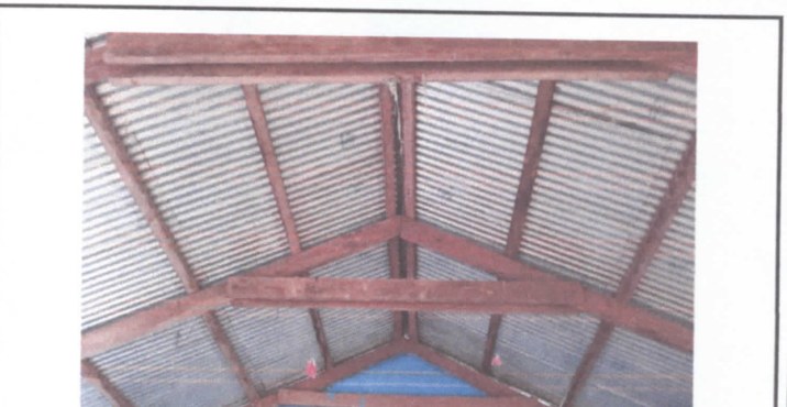
FOTO 4: SUSTITUCION DE ESTRUCTURA DE MADERA POR METAL
