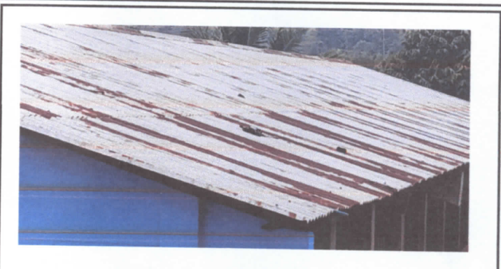
FOTO 2: SUSTITUCION DE LAMINA POR LAMINA TROQUELADA CAL 26
