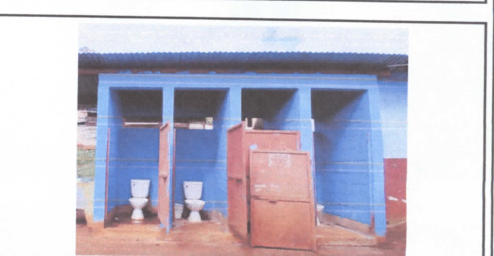
FOTO 6: SUSTITUCION DE PUERTA DE METAL PARA SERVICIOS SANITARIOS
