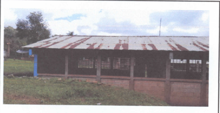
FOTO 3: SUSTITUCION DE LAMINA POR LAMINA TROQUELADA CAL. 26
