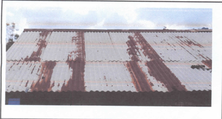
FOTO 1: SUSTITUCION DE LAMINA POR LAMINA TROQUELADA
