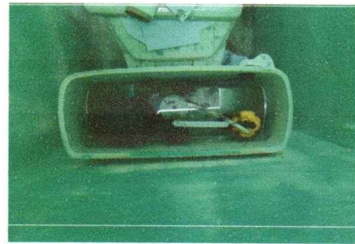
Foto 6: REPACIÓN DE BAÑOS
