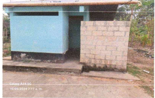
REPELLO DE BAÑOS
