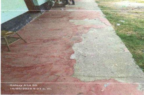
REPACIÓN DE PISO DE TORTA
