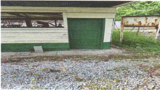
Foto 3: Sustitución de puerta.
