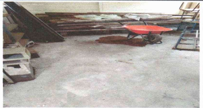
Foto 4: Sustitución de piso de torta de concreto.
