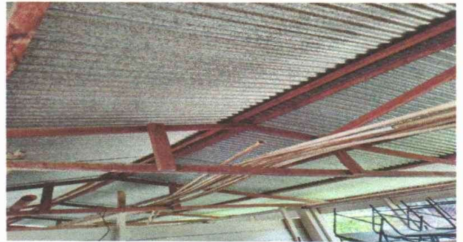
Foto 2: Sustitución de estructura de soporte de madera, por metal.
