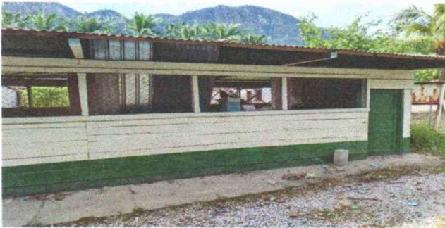
Foto 5: Sustitución de balcones de metal.
