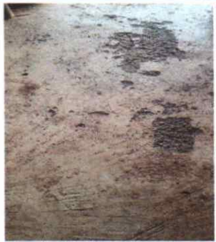
FOTO 3: REPARACION DE PISO TORTA
