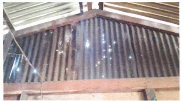
FOTO 2: SUSTITUCION DE ESTRUCTURA DE MADERA POR METAL
