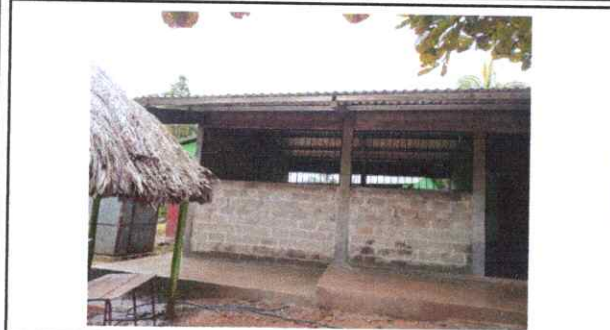
Foto 1: CONSTRUCCION DE PAREDES
