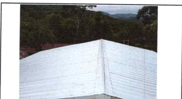
Foto 4: INSTALACION DE LÁMINAS TROQUELADAS
