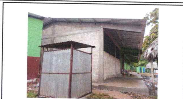
Foto 2: CONSTRUCCION DE VIGAS Y COLUMNAS
