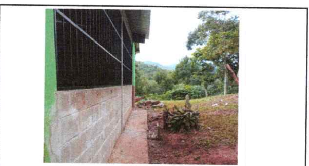
Foto 6: INSTALACION DE BALCONES DE METAL.
