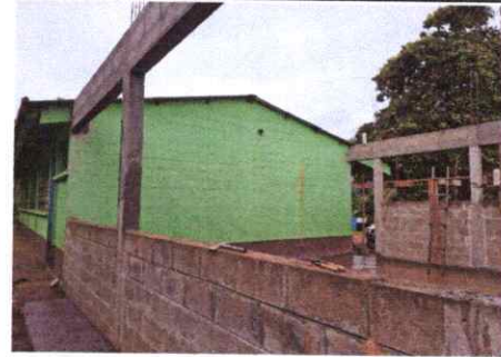
Foto 2: CONSTRUCCION DE VIGAS Y COLUMNAS
