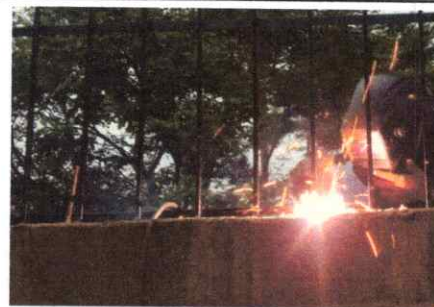
Foto 6: INSTALACION DE BALCONES DE METAL.
