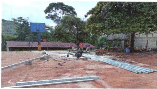
Foto 3: FABRICACION DE ESTRUCTURA DE SOPORTE DE TECHO
