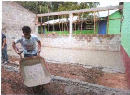
Foto 5: FUNDICION DE PISO DE TORTA DE CONCRETO
