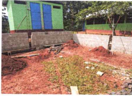
Foto 1: CONSTRUCCION DE PAREDES
