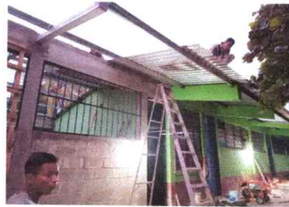
Foto 4: INSTALACION DE LÁMINAS TROQUELADAS
