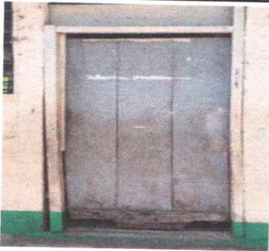
Foto 3: Sustitución de puerta.
