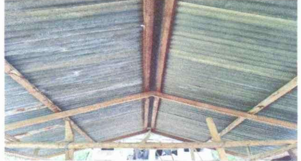
Foto 2: Sustitución de soporte de madera.
