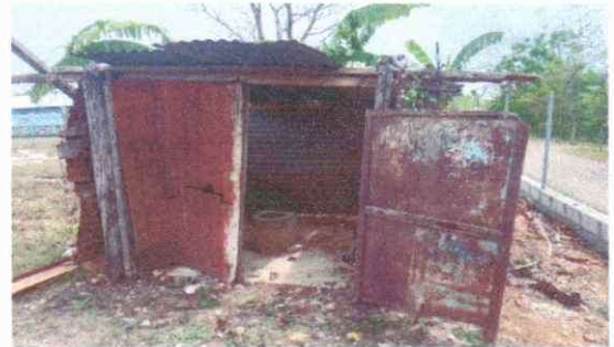
Foto 4: Sustitución de puerta de metal.
