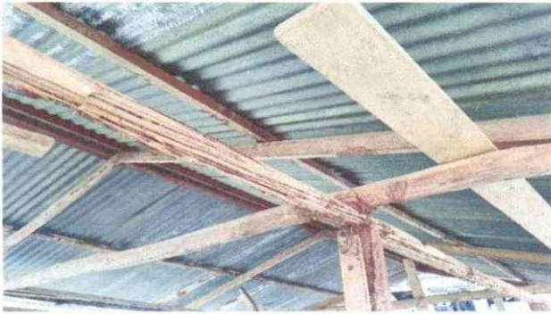
Foto 3: Sustitución de soporte de madera.
