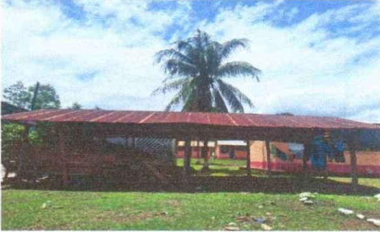
Foto 1: Sustitución de lamina.
