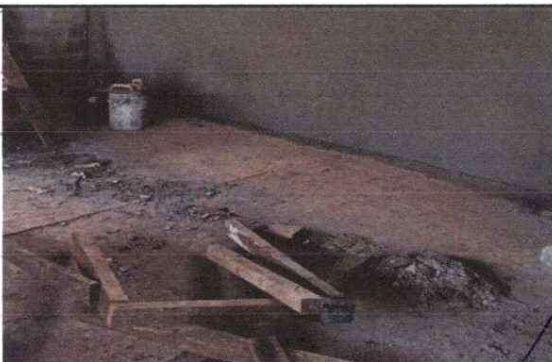
FOTO 5: Sustitución de piso ceramico.
