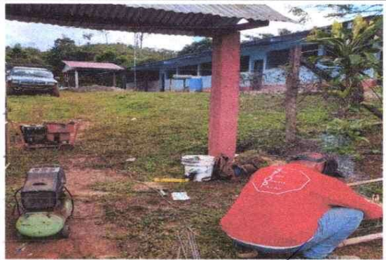
FOTO 2: Sustitución de porton de metal.
