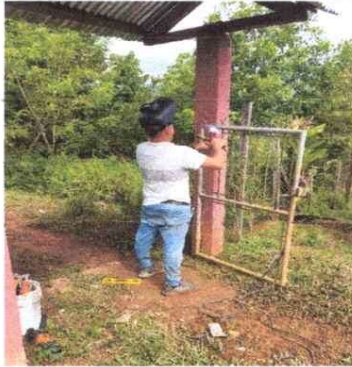
FOTO 1: Sustitución de porton de metal.
