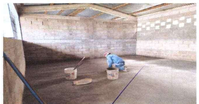
FOTO 6: Sustitución de piso ceramico.
