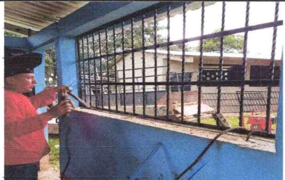
FOTO 4: Sustitución de balcon de metal.
