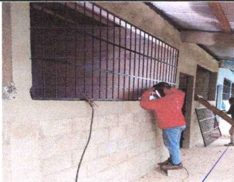
FOTO 3: Sustitución de balcon de metal.
