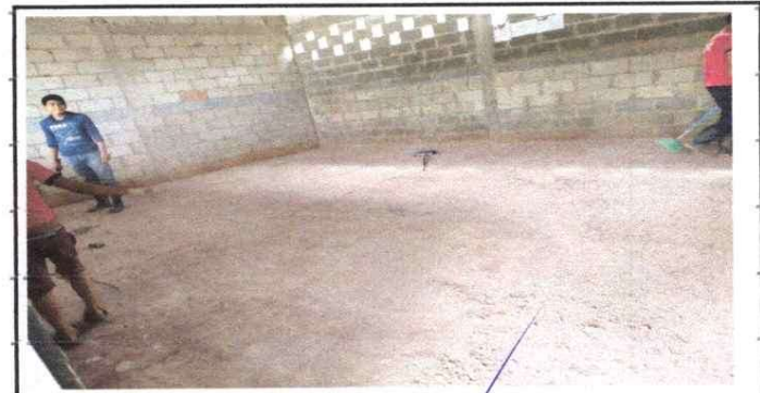
FOTO 6: Sustrucción de piso de torta por concreto
