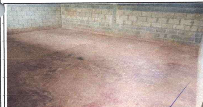
FOTO 5: Sustrucción de piso de torta por concreto.
