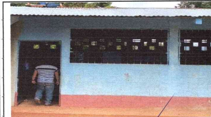
FOTO 3: Sustrucción de balcón de metal.
