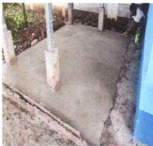
Foto 5: REPARACION DE PISO TORTA DE CONCRETO
