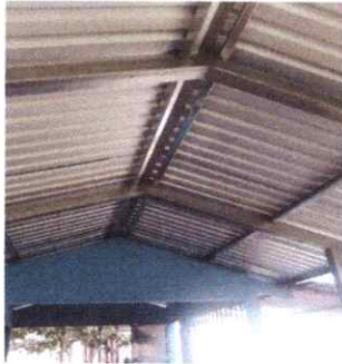
FOTO 1: SUSTITUCION DE LAMINA POR LAMINA TROQUEALDA
