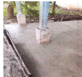
Foto 6: REPARACION DE PISO TORTA DE CONCRETO
