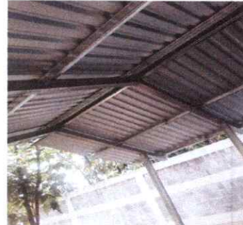
FOTO 2: SUSTITUCION DE ESTRUCTURA DE MADERA POR METAL
