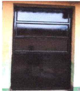
FOTO 3: MANTENIMIENTO PUERTAS DE METAL Y SUSTITUCION DE CHAPA
