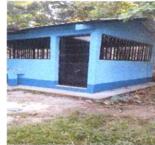
FOTO 4: SUSTITUCION E INSTALACION DE BALCONES DE METAL
