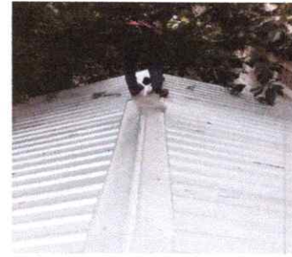
FOTO 2: SUSTITUCION DE LAMINA POR LAMINA TROQUELADA
