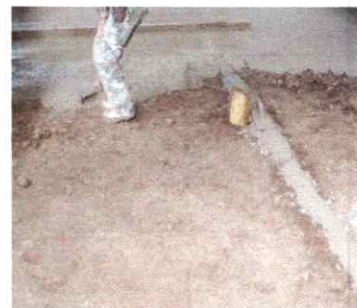
Foto 6: REPARACION DE PISO TORTA DE CONCRETO
