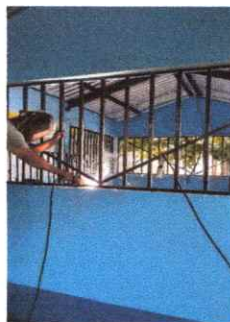
Foto 5: SUSTITUCION DE BALCONES DE MADERA POR METAL EN COCINA
