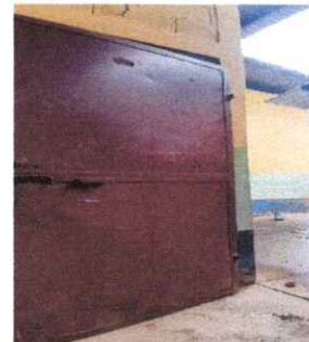
FOTO 4: MANTENIMIENTO PUERTAS DE METAL Y SUSTITUCION DE CHAPA
