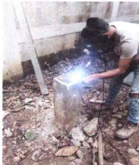
FOTO 3: SUSTITUCION DE ESTRUCTURA DE MADERA POR METAL
