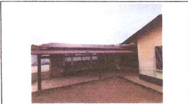
FOTO 1: SUSTITUCION DE LAMINA POR LAMINA TROQUEALDA
