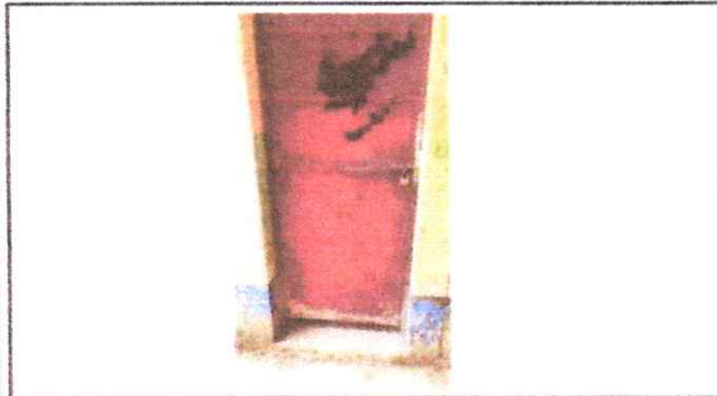
FOTO 3: MANTENIMIENTO PUERTAS DE METAL Y SUSTITUCION DE CHAPA
