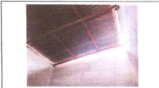
FOTO 2: SUSTITUCION DE ESTRUCTURA DE MADERA POR METAL
