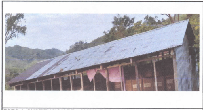
FOTO 1: SUSTITUCION DE LAMINA POR LAMINA TROQUELADA
