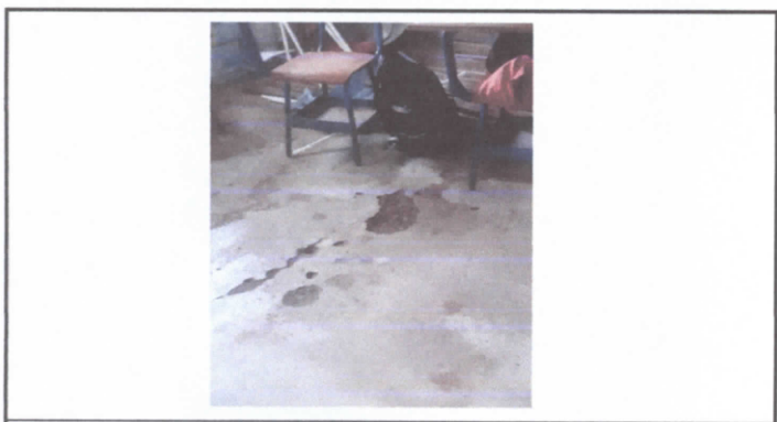
FOTO 3: REPARACION DE PISO TORTA
