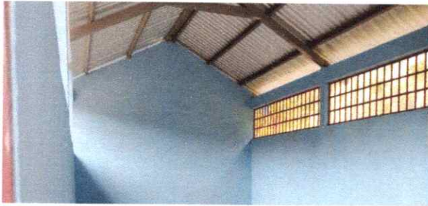
FOTO 3: SUSTITUCION DE ESTRUCTURA DE MADERA POR METAL
