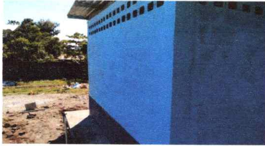
FOTO 13: PINTURA MURO INTERIOR Y EXTERIOR
