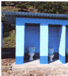
FOTO 17: PINTURA MURO INTERIOR Y EXTERIOR
