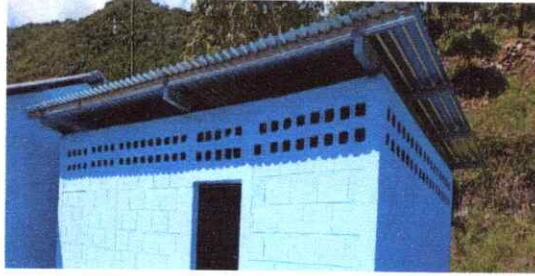
FOTO 1: SUSTITUCION DE LAMINA POR LAMINA TROQUELADA
