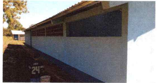
FOTO 14: PINTURA MURO INTERIOR Y EXTERIOR
