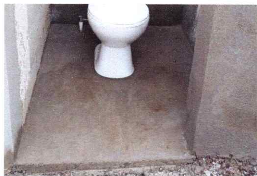
FOTO 10: INSTALACION DE PISO TORTA
