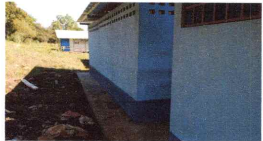
FOTO 16: PINTURA MURO INTERIOR Y EXTERIOR
