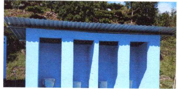
FOTO 2: SUSTITUCION DE LAMINA POR LAMINA TROQUELADA
