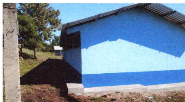
FOTO 12: PINTURA MURO INTERIOR Y EXTERIOR
