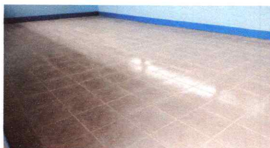
FOTO 8: INSTALACION DE PISO CERAMICO
