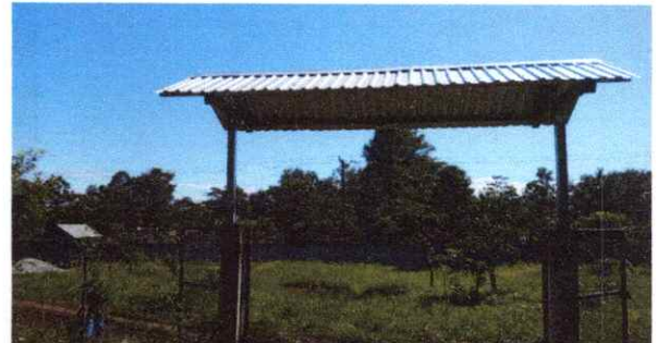
FOTO 18: TECHO PARA ENTRADA PRINCIPAL
