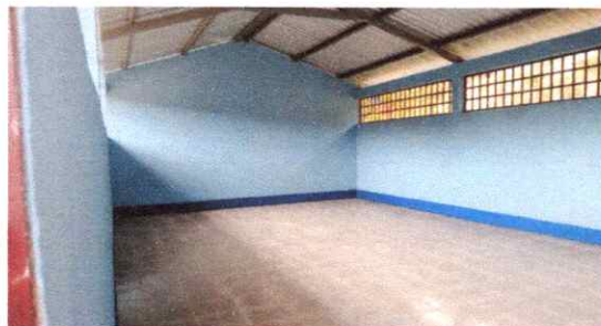
FOTO 9: INSTALACION DE PISO CERAMICO
