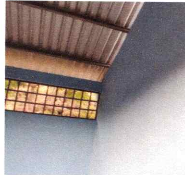
FOTO 4: SUSTITUCION DE ESTRUCTURA DE MADERA POR METAL
