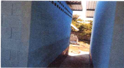
FOTO 15: PINTURA MURO INTERIOR Y EXTERIOR
