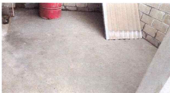
FOTO 11: INSTALACION DE PISO TORTA
