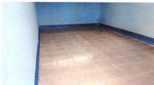
FOTO 7: INSTALACION DE PISO CERAMICO
