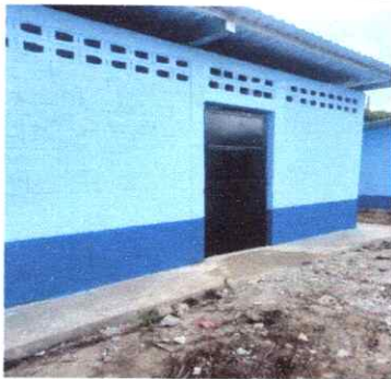
FOTO 5: LEVANTADO DE MURO EN COCINA
