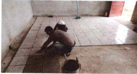
FOTO 7: INSTALACION DE PISO CERAMICO
