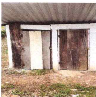
Foto 5: RECONSTRUCCION Y REMODELACION DE BAÑOS
