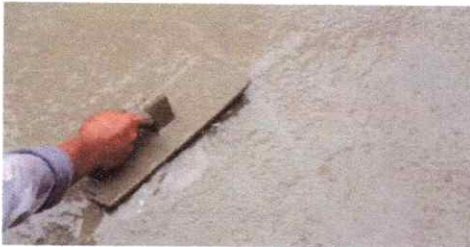
FOTO 9: INSTALACION DE PISO TORTA
