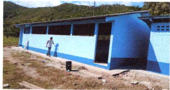
FOTO 10: PINTURA EN MURO INTERIOR Y EXTERIOR
