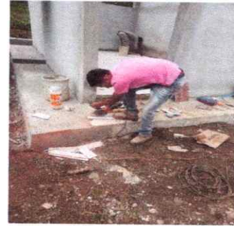
FOTO 8: INSTALACION DE PISO CERAMICO
