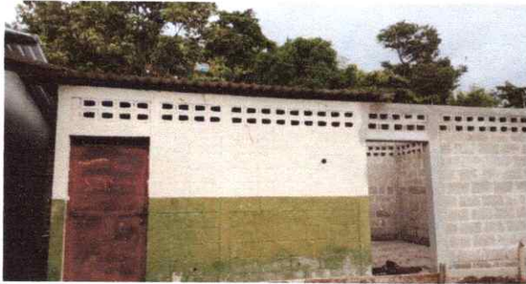
FOTO 1: SUSTITUCION DE LAMINA POR LAMINA TROQUELADA
