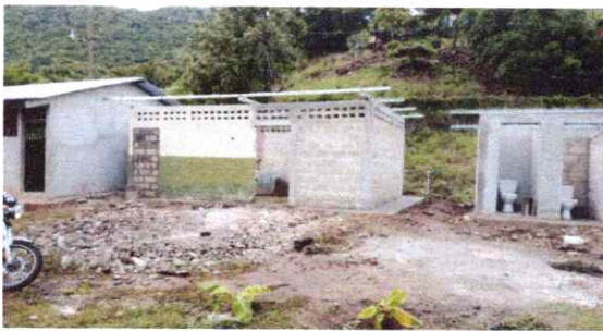
FOTO 2: SUSTITUCION DE ESTRUCTURA DE MADERA POR METAL
