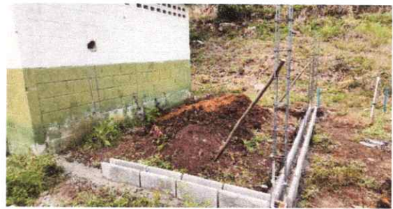
FOTO 3: LEVANTADO DE MURO EN COCINA
