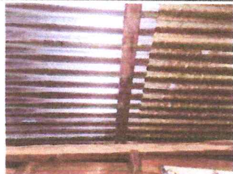
FOTO 2: SUSTITUCION DE ESTRUCTURA DE MADERA POR METAL
