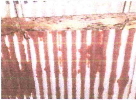
FOTO 1: SUSTITUCION DE LAMINA POR LAMINA TROQUEALDA
