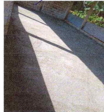
Foto 4: Sustitución de piso de cemento líquido
