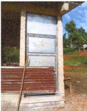
Foto 3: Sustitución de puerta
