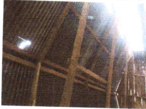
Foto 1: Sustitución de lámina, por lámina troquelada aluzinc calibre 26
