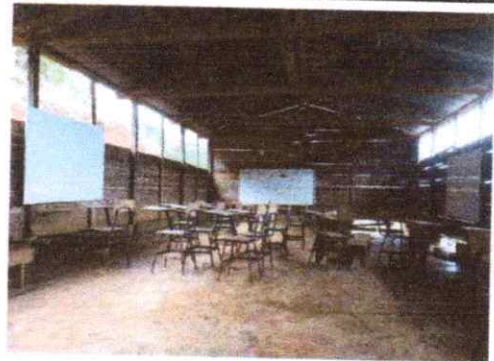
Foto 4: Sustitución de piso de cemento líquido
