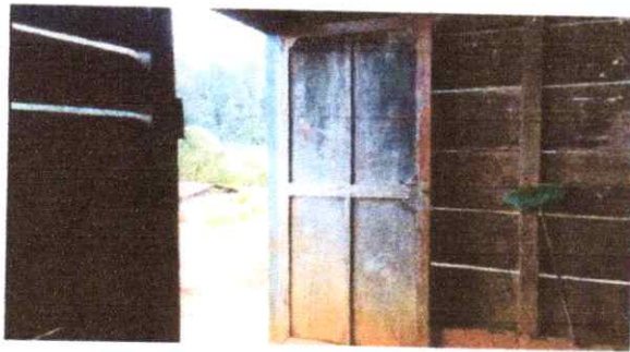
Foto 3: Sustitución de puerta
