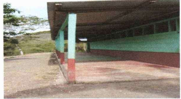
Foto 4: Reparación de piso de torta de concreto
