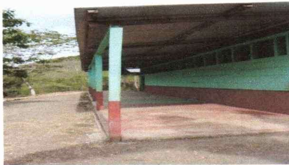
Foto 5: Sustitución de balcones de metal
