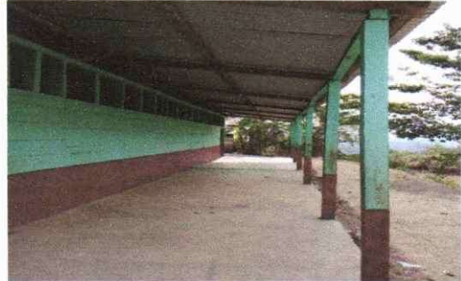
Foto 2: Sustitución de estructura de madera por metal
