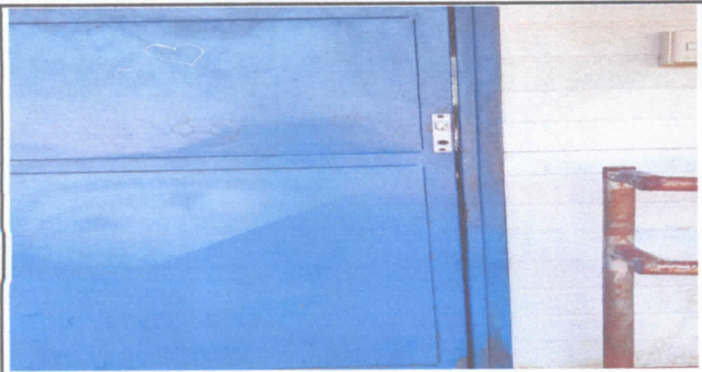
FOTO 1: Sustitución de chapa de metal grande.
