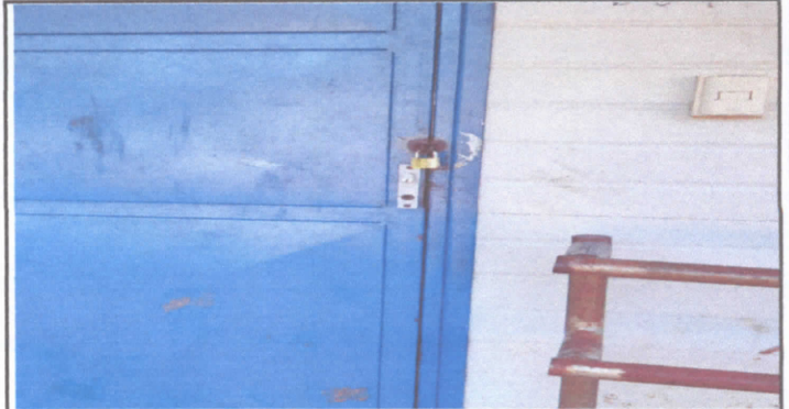
FOTO 2: Sustitución de chapa de metal grande.
