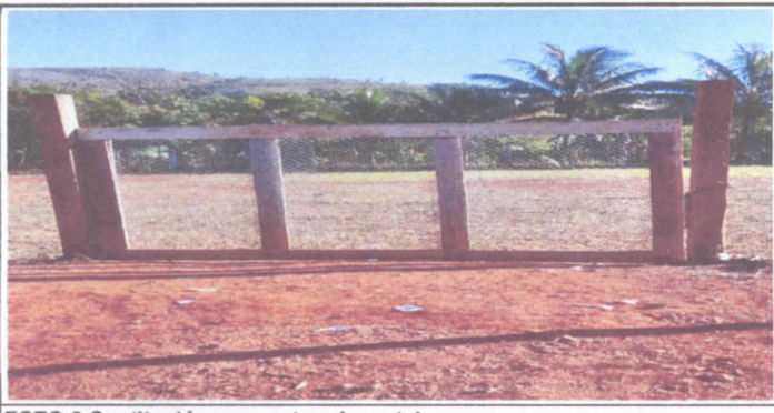
FOTO 6: Sustitución por porton de metal.
