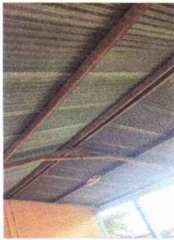
Foto1: Sustitución de lamina por Lamina Troquelada Cal. 26
