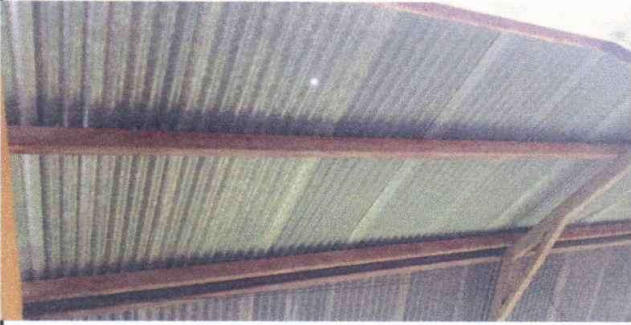
Foto1: Sustitución de lamina por Lamina Troquelada Cal. 26
