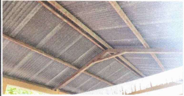
Foto 2: Sustitución estructura de soporte de madera por metal
