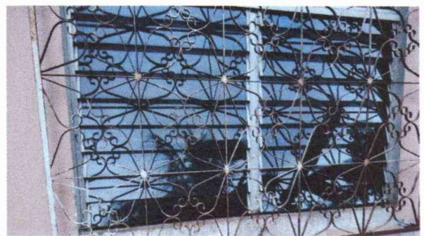
Foto 2: Sustitución estructura de soporte de madera por metal
