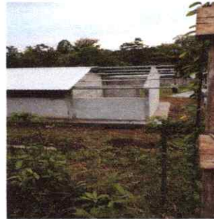
FOTO 4: LEVANTADO DE MURO EN DIRECCION
