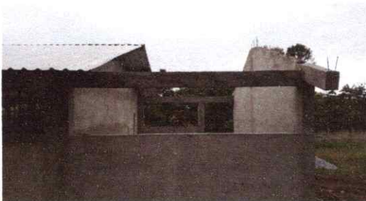
FOTO 5: LEVANTADO DE MURO EN DIRECCION
