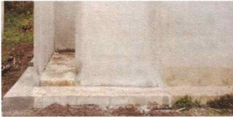
FOTO 3: REPARACION PISO TORTA
