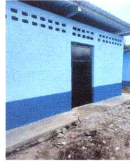
FOTO 8: INSTALACION DE PUERTAS DE METAL
