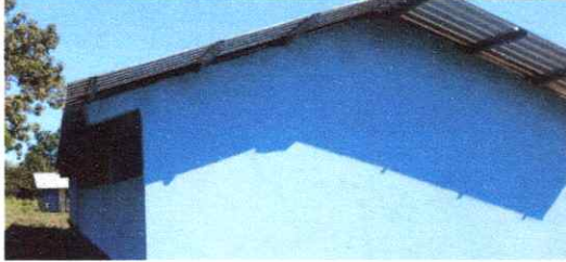
FOTO 1: SUSTITUCION DE LAMINA POR LAMINA TROQUEALDA
