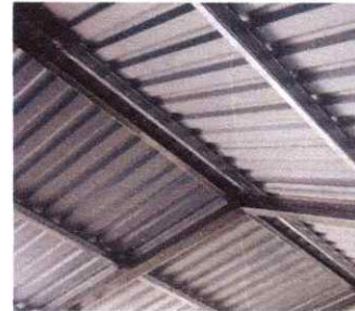
FOTO 2: SUSTITUCION DE ESTRUCTURA DE MADERA POR METAL
