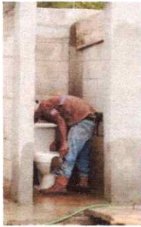
FOTO 9: INSTALACION DE SANITARIOS
