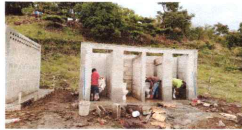
FOTO 8: INSTALACION DE SANITARIOS
