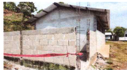
Foto 6: LEVANTADO DE MURO EN DIRECCION
