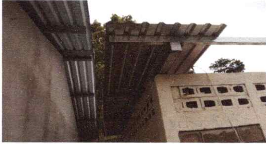
FOTO 1: SUSTITUCION DE LAMINA POR LAMINA TROQUEALDA
