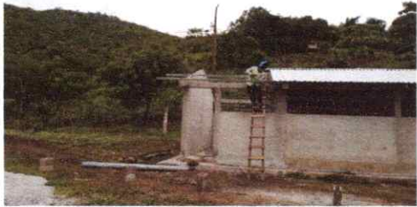
FOTO 3: SUSTITUCION DE ESTRUCTURA DE MADERA POR METAL
