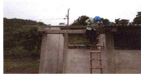
FOTO 4: SUSTITUCION DE ESTRUCTURA DE MADERA POR METAL
