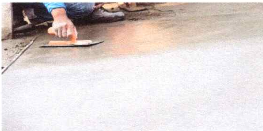
FOTO 5: REPARACION PISO TORTA
