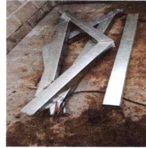
FOTO 2: SUSTITUCION DE ESTRUCTURA DE MADERA POR METAL
