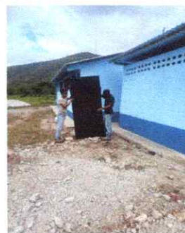
FOTO 12: INSTALACION DE PUERTAS DE METAL
