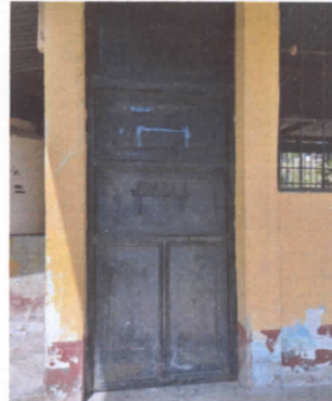
FOTO 2: Mantenimiento a estructura (lijado, cambio de tubo, cepillado, sujeciones, aplicación de pintura)
