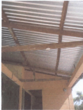
FOTO 1: Sustitución de estructura de soporte de madera, por metal
