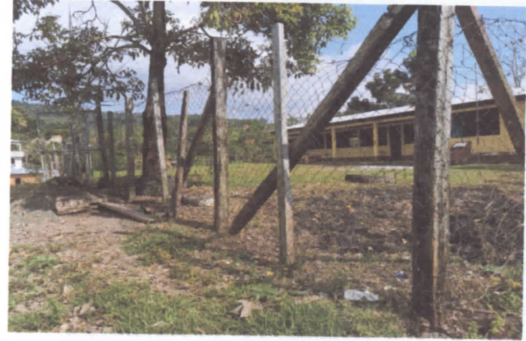
FOTO 7: Reparación de cerco
