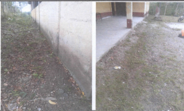
FOTO 3: Cuneta de Concreto
