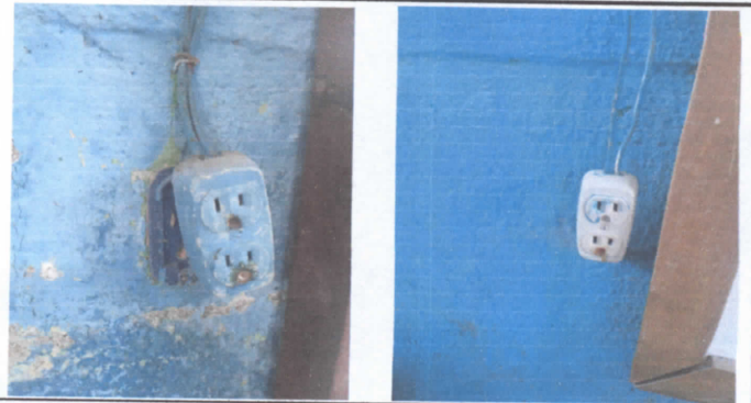
FOTO 8: Sustitucion tomacorrientes dobles
