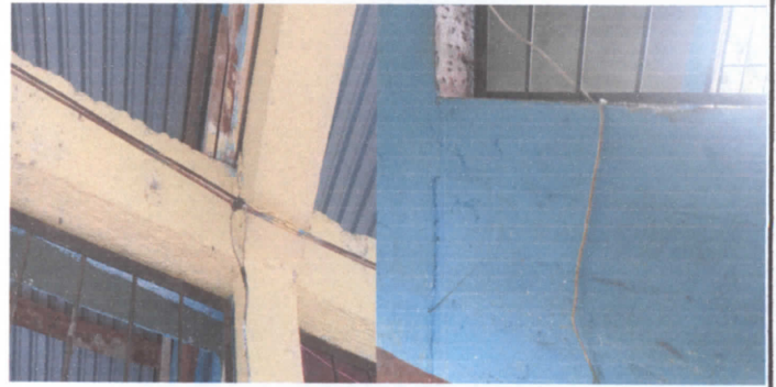
FOTO 8: Reparacion de Cableado Electrico
