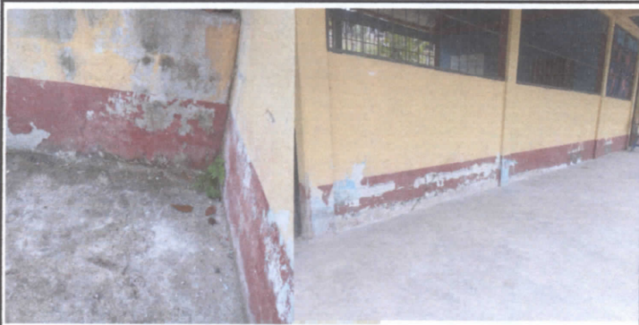
FOTO 9: Repello en Muro de pared
