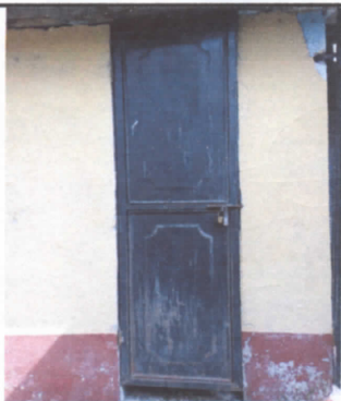
FOTO 5: Mantenimiento a estructura (lijado, cambio d tubo, cepillado, sujeciones, aplicación de pintura a puertas servicios sanitarios)
