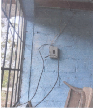
FOTO 8: Sustitucion de filpones
