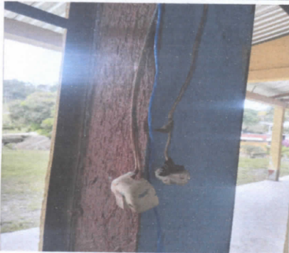
FOTO 8: Sustitucion interruptores simples
