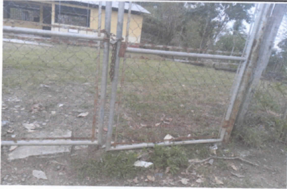
FOTO 6: Mantenimiento a portone de metal
