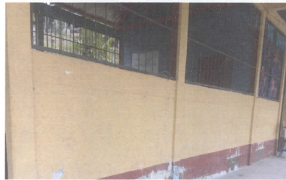
FOTO 4: Pintura en muros exteriores e interiores
