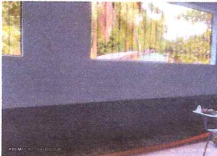
Foto 9: PINTURA INTERIOR Y EXTERIOR
