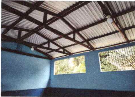
Foto 13: REPARACION DE SISTEMA ELECTRICO
