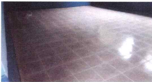
FOTO 5: INSTALACION DE PISO CERAMICO
