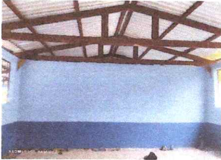
Foto 7: PINTURA INTERIOR Y EXTERIOR
