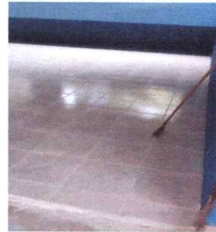
FOTO 4: INSTALACION DE PISO CERAMICO
