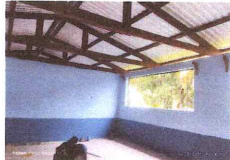
Foto 8: PINTURA INTERIOR Y EXTERIOR
