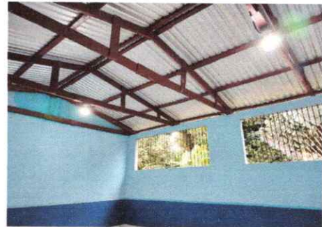
Foto 13: REPARACION DE SISTEMA ELECTRICO
