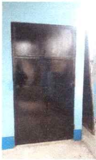
Foto 3: SUSTITUCION DE PUERTAS DE METAL
