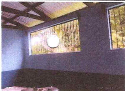
Foto 11: PINTURA INTERIOR Y EXTERIOR
