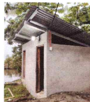
Foto 13: REPARACION DE SISTEMA ELECTRICO
