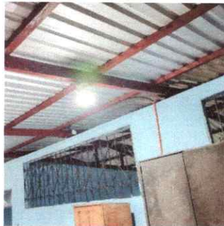
Foto 13: REPARACION DE SISTEMA ELECTRICO
