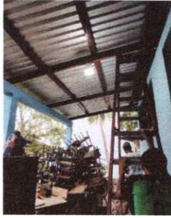
FOTO 7: REPARACION DE SISTEMA ELECTRICO
