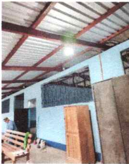
FOTO 9: REPARACION DE SISTEMA ELECTRICO
