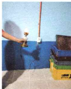
FOTO 11: REPARACION DE SISTEMA ELECTRICO
