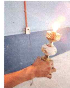
FOTO 10: REPARACION DE SISTEMA ELECTRICO
