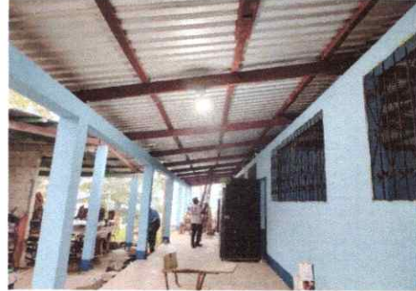
FOTO 8: REPARACION DE SISTEMA ELECTRICO
