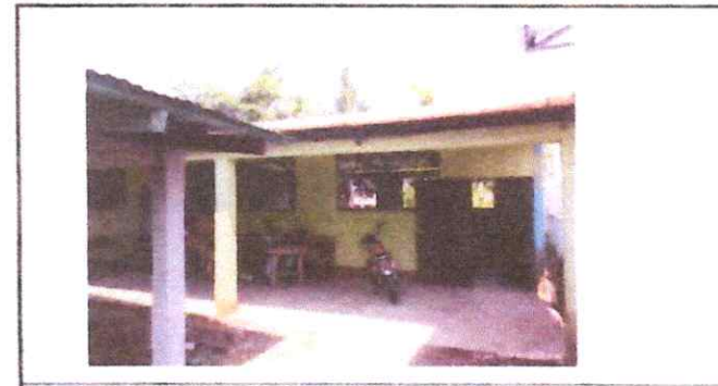
Foto 6: SUSTITUCION DE CANALES DE AGUA PLUVIAL
