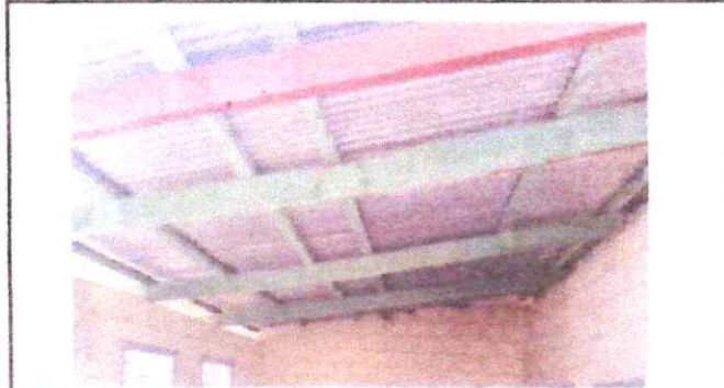
FOTO 2: SUSTITUCION DE ESTRUCTURA DE MADERA POR METAL
