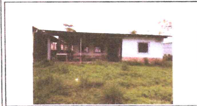
Foto 5: PINTURA MURO INTERIOR Y EXTERIOR
