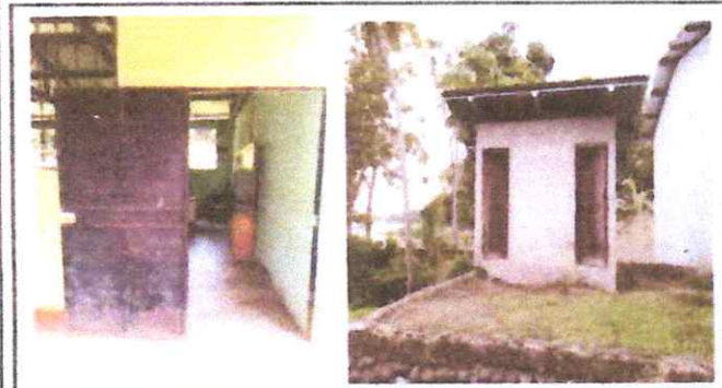
FOTO 3: SUSTITUCION DE PUERTAS DE METAL
