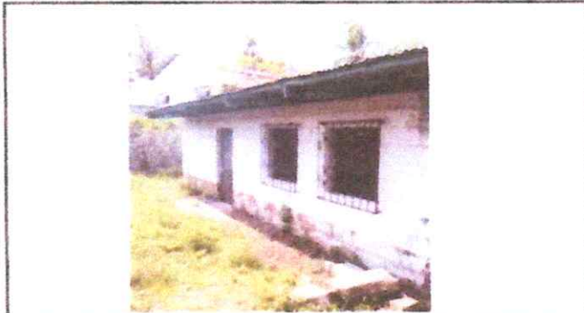
FOTO 1: SUSTITUCION DE LAMINA POR LAMINA TROQUELADA CAL 26
