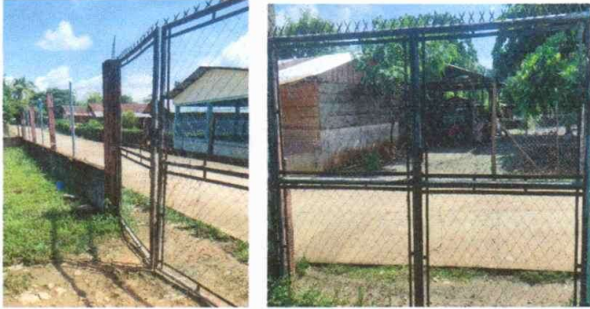
Foto1: Mantenimiento a portones de metal
