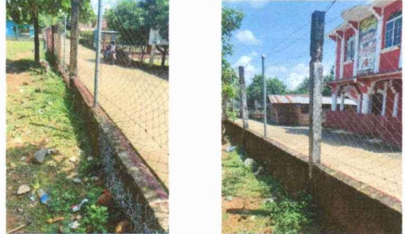
Foto 2: Reparación de muro perimetral de block con tubo hg y malla galvanizada.
