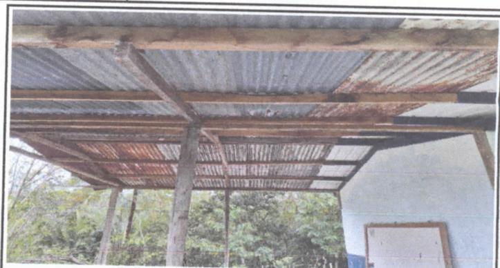
SUSTITUCION DE COSTANERAS Y BASES DE MADERA A METAL
