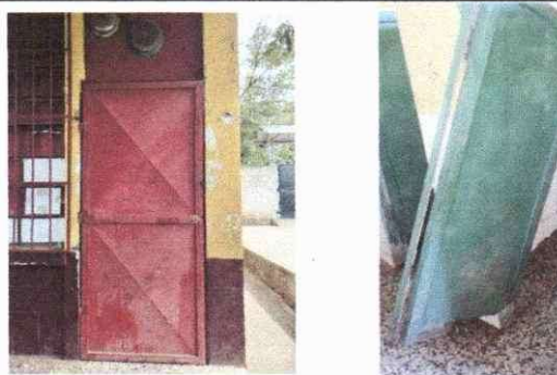
FOTO 4: MANTENIMIENTO Y SUSTITUCION DE PUERTAS DE METAL
