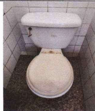
FOTO 2: SUSTITUCION DE SANITARIOS
