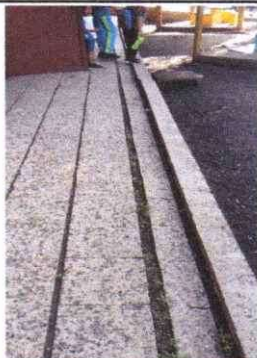
FOTO 1: REPARACION DE PISO DE GRANITO
