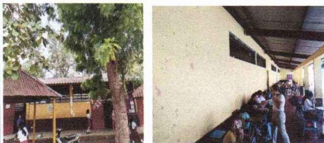
FOTO 3: PINTURA MUROS INTERIOR Y EXTERIOR
