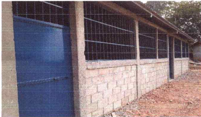
3. INSTALACION DE 2 PUERTAS.
