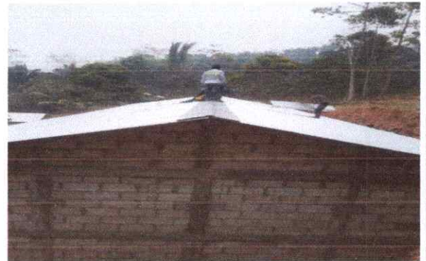
2. INSTALACIÓN DE LAMINAS.
