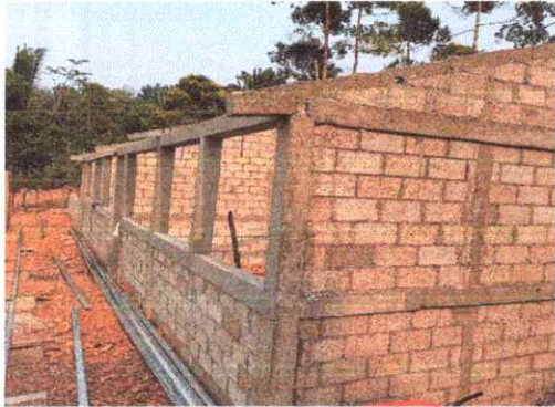
1. AVANTAMIENTO DE MURO.
