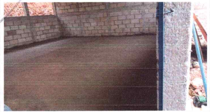
4. REMODELACIÓN DE PISO DE TORTA A PISO LISO.
