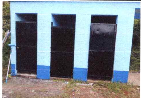
FOTO 6: PINTURA MURO INTERIOR Y EXTERIOR
