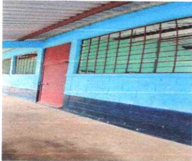
FOTO 3: PINTURA MURO INTERIOR Y EXTERIOR
