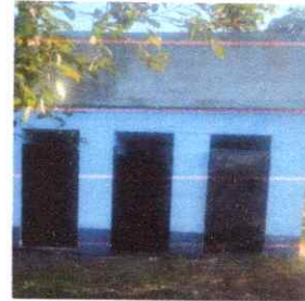
FOTO 10: MANTENIMIENTO Y SUSTITUCION DE PUERTAS
