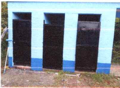
FOTO 11: MANTENIMIENTO Y SUSTITUCION DE PUERTAS
