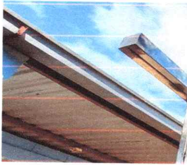
FOTO 7: SUSTITUCION DE CANALES Y BAJADAS DE AGUA PLUVIAL
