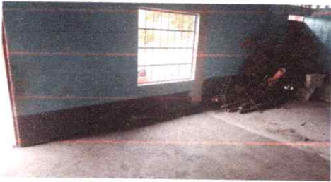
FOTO 14: DEMOLICION DE PARED
