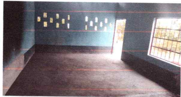
FOTO 10: INSTALACION DE PISO TORTA
