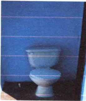
FOTO 9: SUSTITUCION DE SANITARIOS
