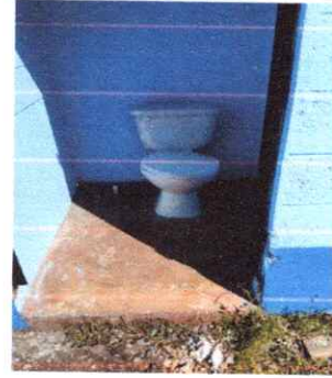
FOTO 8: SUSTITUCION DE SANITARIOS
