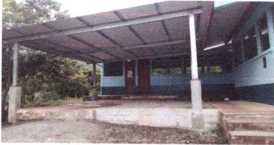
FOTO 1: SUSTITUCION DE LAMINA POR LAMINA TROQUELADA
