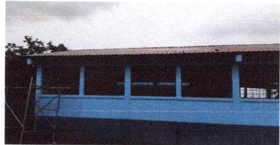
FOTO 4: PINTURA MURO INTERIOR Y EXTERIOR
