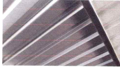
FOTO 2: MANTENIMIENTO ESTRUCTURA DE METAL
