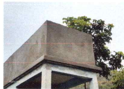
Foto 19: MANTENIMIENTO DEPOSITO DE AGUA
