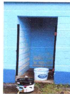
Foto 12: MANTENIMIENTO Y SUSTITUCION PUERTA DE METAL
