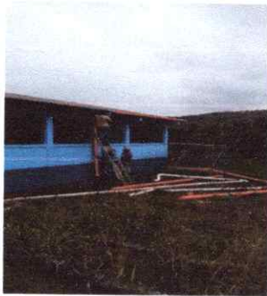
FOTO 9: SUSTITUCION DE CANALES Y BAJADAS DE AGUA PLUVIAL
