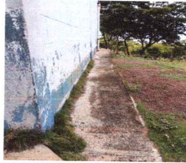
FOTO 8: PINTURA MURO INTERIOR Y EXTERIOR
