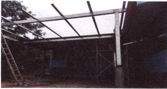
FOTO 3: SUSTITUCION DE ESTRUCTURA DE METAL
