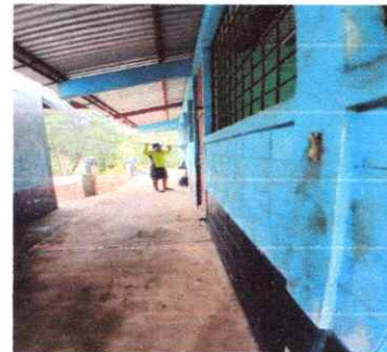
FOTO 6: PINTURA MURO INTERIOR Y EXTERIOR
