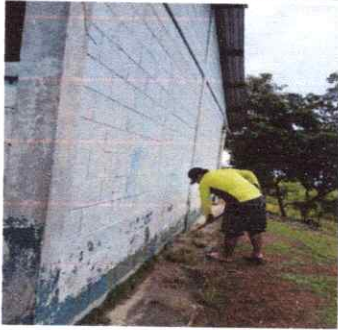
FOTO 7: PINTURA MURO INTERIOR Y EXTERIOR
