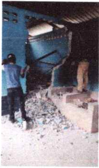
FOTO 13: DEMOLICION DE PARED
