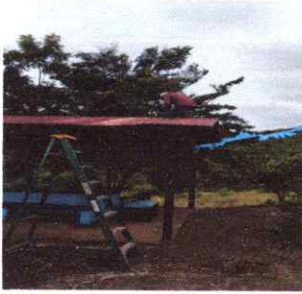
FOTO 1: SUSTITUCION DE LAMINA POR LAMINA TROQUELADA
