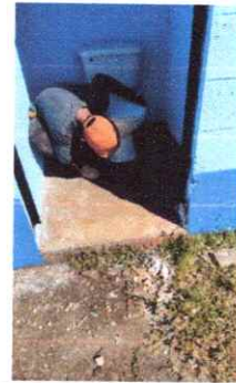
FOTO 10: SUSTITUCION DE SANITARIOS
