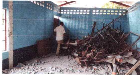
FOTO 16: DEMOLICION DE PARED
