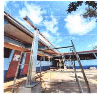
FOTO 4: SUSTITUCION DE ESTRUCTURA DE METAL
