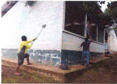
FOTO 5: PINTURA MURO INTERIOR Y EXTERIOR
