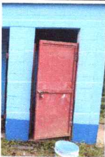
Foto 11: MANTENIMIENTO Y SUSTITUCION PUERTA DE METAL
