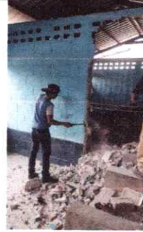
FOTO 14: DEMOLICION DE PARED
