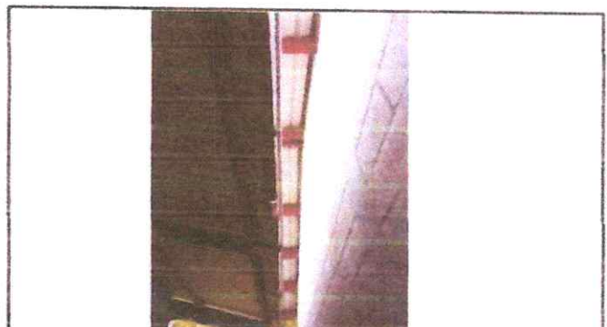
FOTO 4: SUSTITUCION DE CANALES Y BAJADAS DE AGUA PLUVIAL
