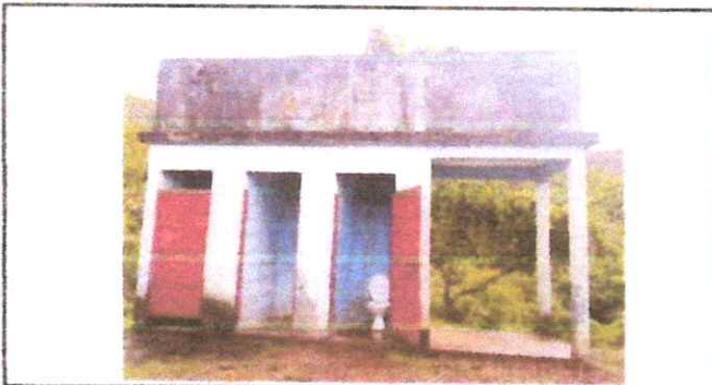
Foto 5: SUSTITUCION DE SANITARIO
