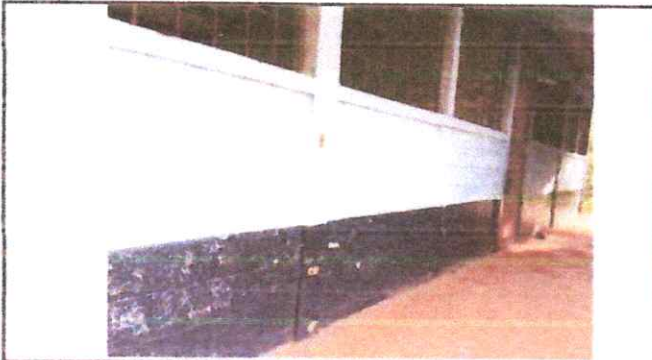
FOTO 3: PINTURA MURO INTERIOR Y EXTERIOR
