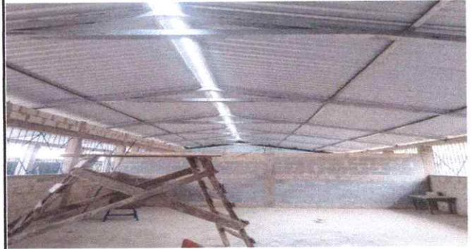
FOTO 2: FABRICACIÓN E INSTALACIÓN DE ESTRUCTURA METALICA
