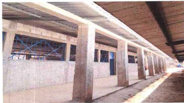
FOTO 5: REMODELACIÓN DE COLUMNAS Y VIGAS.
