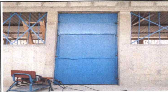
FOTO 3: FABRICACIÓN E INSTALACION DE PUERTAS PRINCIPALES.
