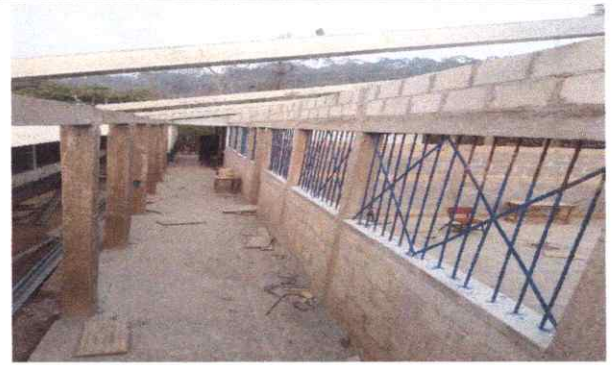
FOTO 2: FABRICACIÓN E INSTALACIÓN DE ESTRUCTURA METALICA
