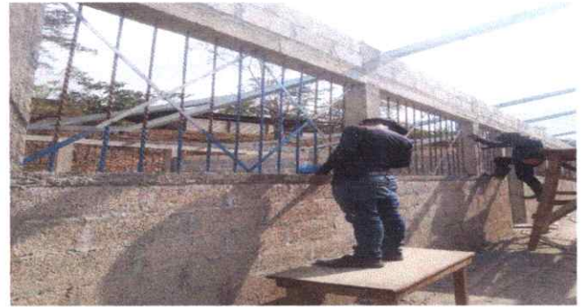
FOTO 4: FABRICACIÓN E INSTALACIÓN DE BALCONES DE METAL
