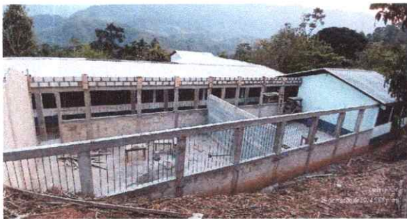
FOTO 5: REMODELACIÓN DE COLUMNAS Y VIGAS.
