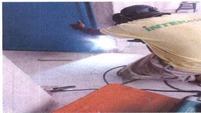
FOTO 3: FABRICACIÓN E INSTALACION DE PUERTAS PRINCIPALES.
