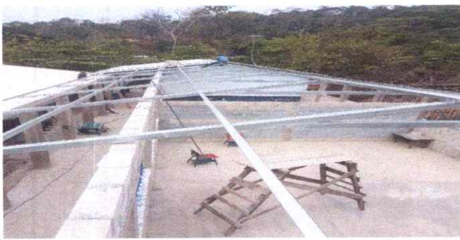
FOTO 1: INSTALACIÓN DE LAMINAS TROQUELADAS.
