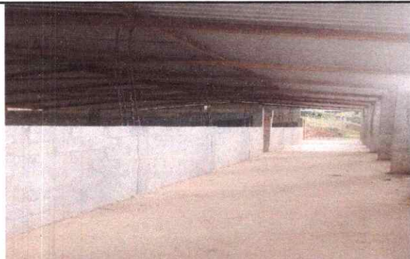
FOTO 5: REMODELACION DE COLUMNAS Y VIGAS.
