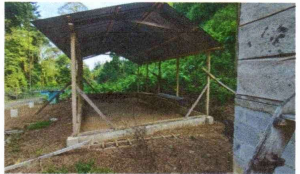
Foto 4: Sustitución de piso de torta de concreto.
